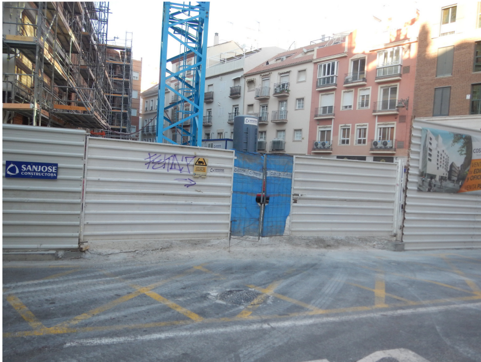
Atarazanas, zona de obras.
