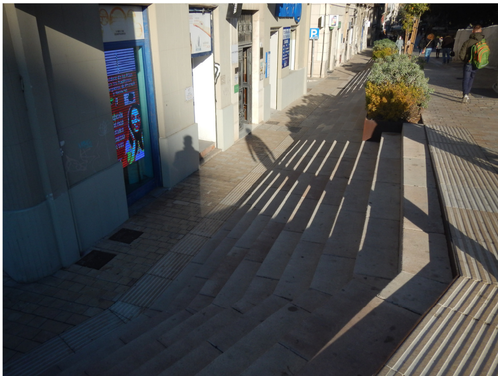
Alameda principal-Tetuán, posibles caídas a distinto nivel.
