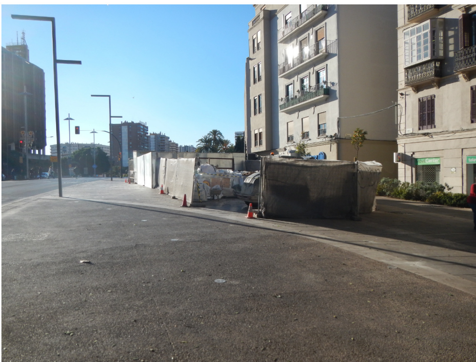
Alameda principal, obras del metro
