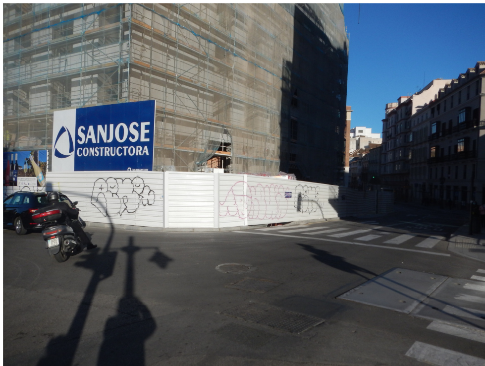
Atarazanas, zona de obras.
