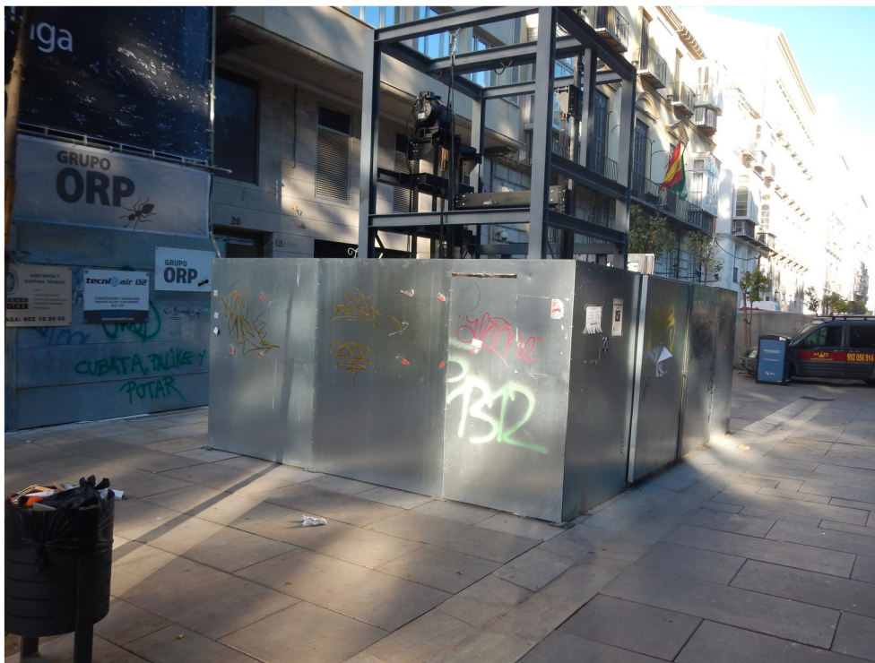
Alameda principal, obras del metro
