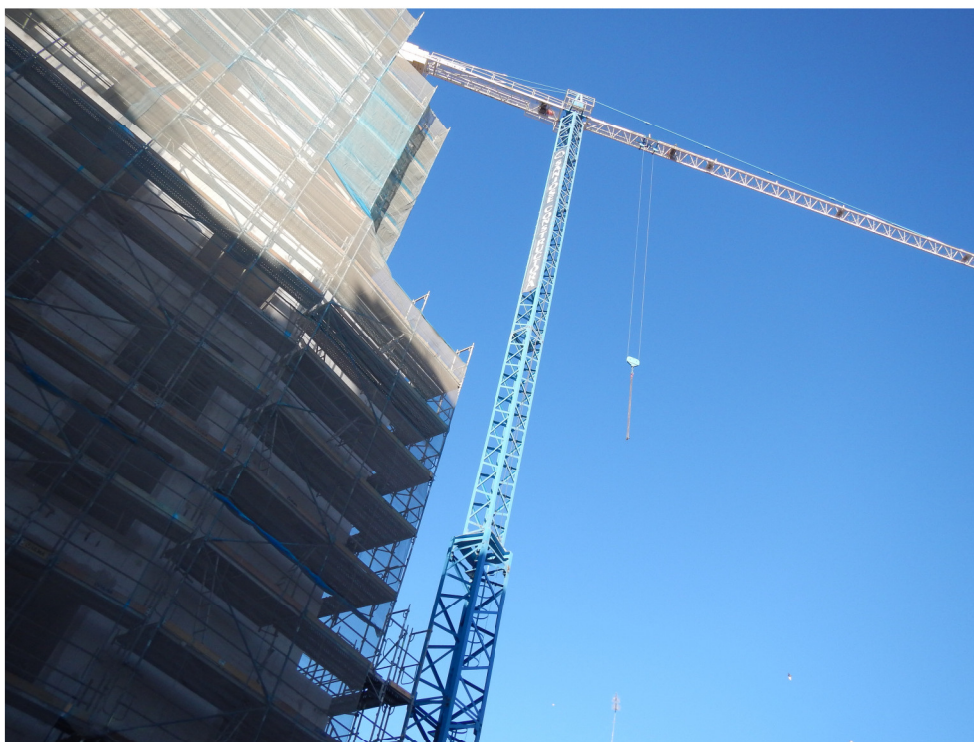
Atarazanas, zona de obras.
