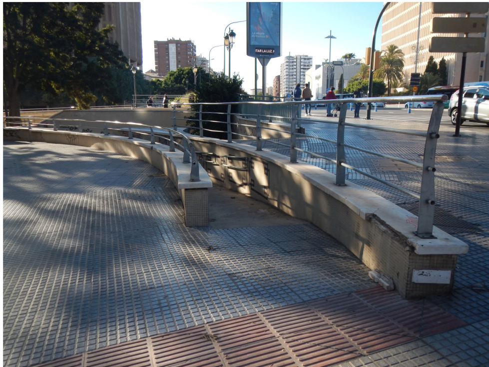
Alameda principal-Tetuán, posibles caídas a distinto nivel.
